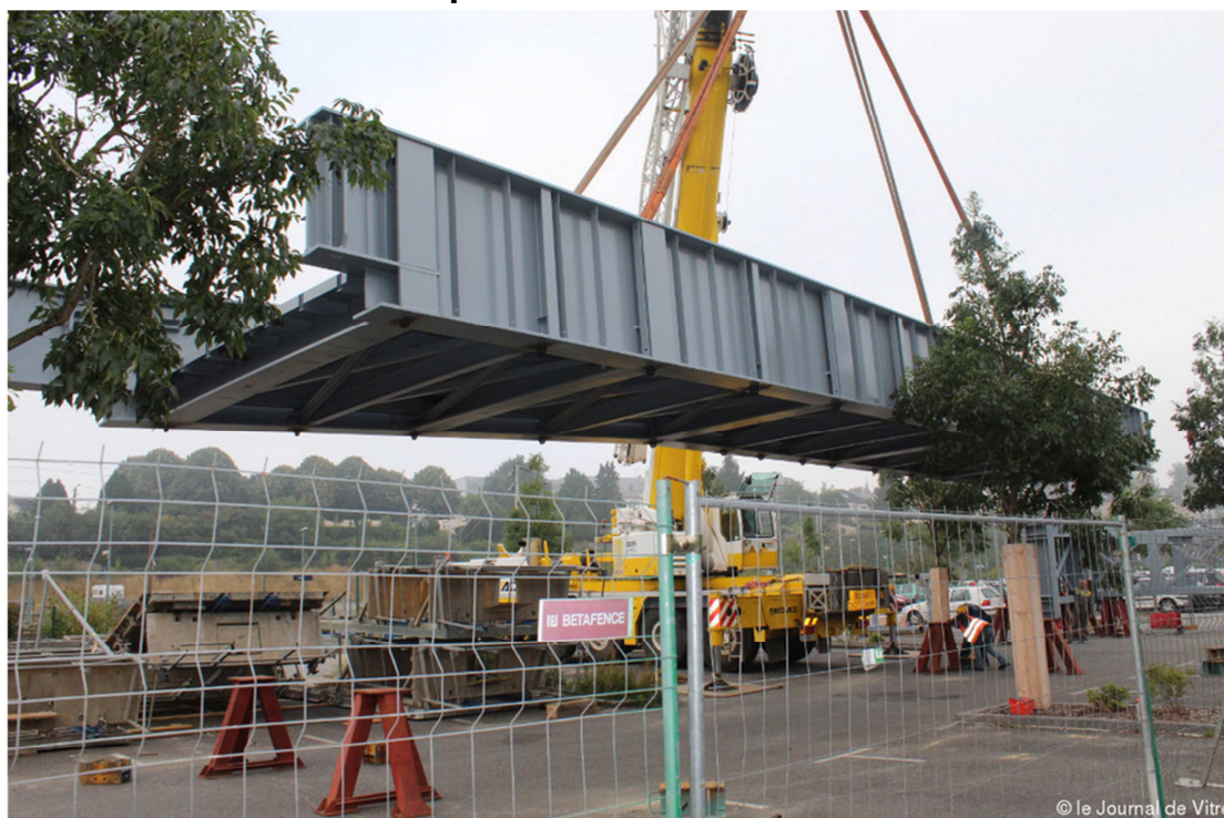
La passerelle a été déchargée de mardi matin à la gare de Vitré
